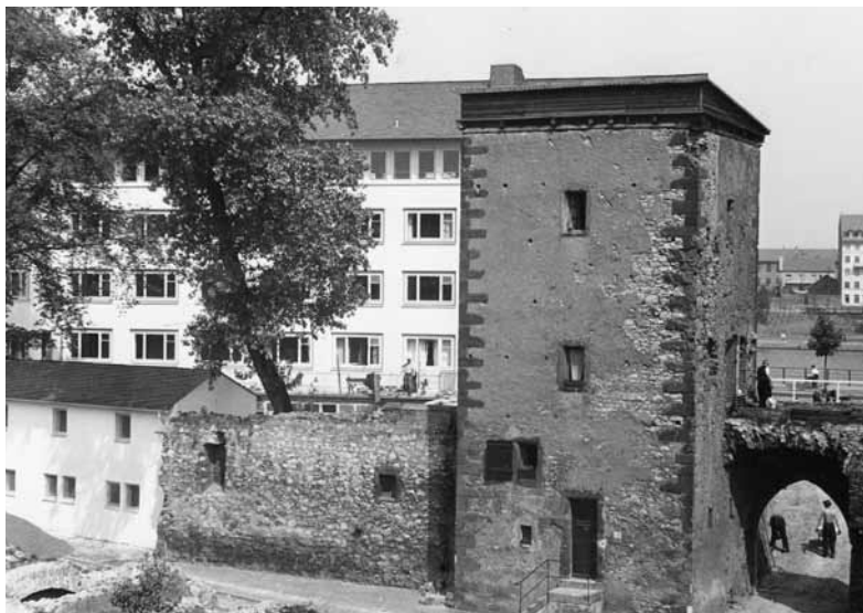
Abb. unten: Nach dem Zweiten Weltkrieg erhielt der Kuhhirtenturm zum Schutz des Mauerwerks ein Notdach, Fotografie von Musiol, 1952 © Institut für Stadtgeschichte
