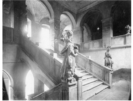
Treppenhaus 1900; © Institut für Stadtgeschichte
