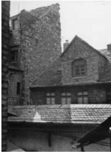
Wohnturm in der Paradiesgasse, Fotografie von Alfred Ehrhardt um 1930; © Institut für Stadtgeschichte
