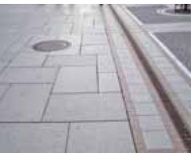
Bodenbelag im Übergangsbereich zwischen Kleinpflaster und Großplatten
