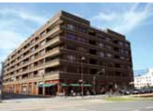
verdichtete Baustruktur Zanderstraße
