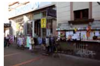
Fassade Berger Straße
