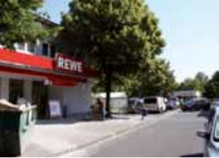
Zeilsheim, modernisierter/ erweiterter Lebensmittel-SB- Markt Bechtenwaldstraße
