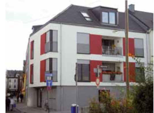
Geförderter Wohnungsbau im Rahmenplangebiet Höchst
