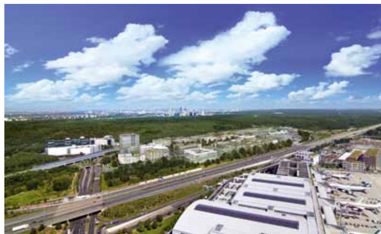
Gateway Gardens – Blick Richtung Frankfurt am Main © Grundstücksgesellschaft Gateway Gardens GmbH
