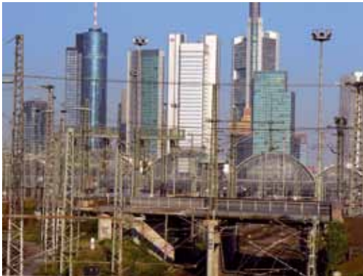
Gleisvorfeld Frankfurter Hauptbahnhof
