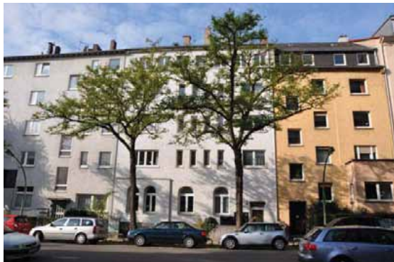
Gräfstraße, Frankfurt am Main
