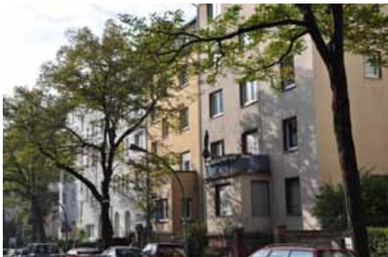
Gräfstraße, Frankfurt am Main
