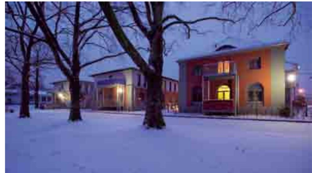
samen Rahmens – eine wirtschaftliche Bauweise, die dennoch eine abwechslungsreiche Architektur mit vielfältigen Wohnungstypen zulässt. Für das Fundament, die Kelleraußenwände und die Kellerdecke wurde Stahlbeton verwendet. Die Innenwände der Keller sind aus Kalksandstein gefertigt, die Außenwände bestehen aus Kalksandstein bzw. Stahlbeton und einer Thermohaut.
