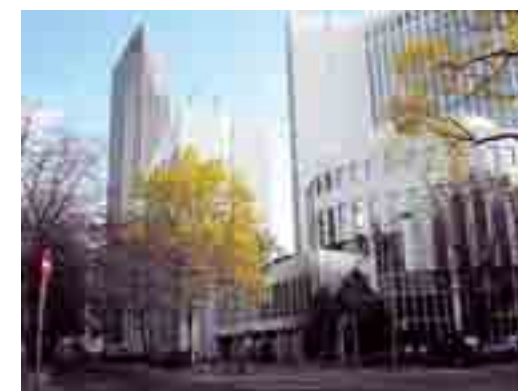
Poseidonhaus (vorher), Bestand
