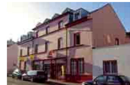
Braumannstraße 2, 2a nach der Modernisierung
