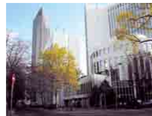
Poseidonhaus (vorher), Bestand
