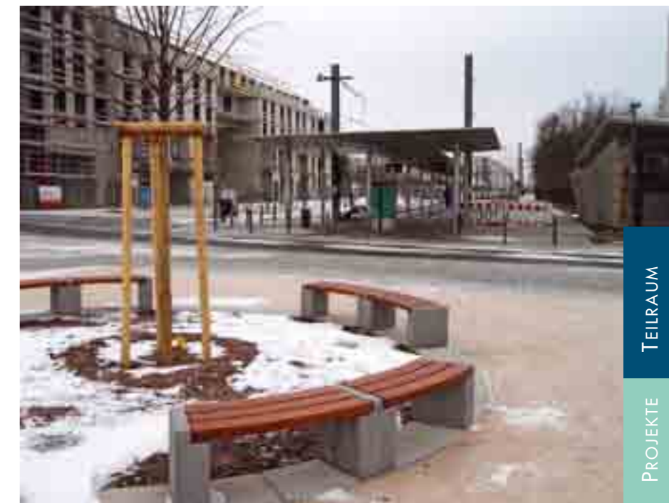
Gravensteiner Platz, Blick zur Endhaltestelle der neu eröffneten Straßenbahn Linie 18
