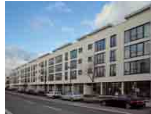
Mehrfamilienhaus an der Altenhöferallee © GSW GmbH
