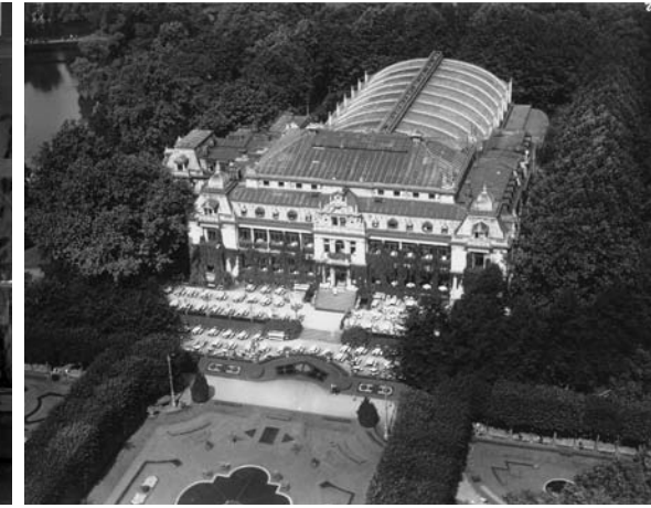
Gesellschaftshaus Palmengarten, Luftbild, 1927
