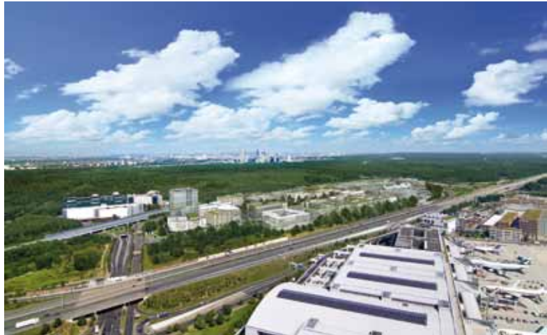
Gateway Gardens © Grundstücksgesellschaft Gateway Gardens GmbH
