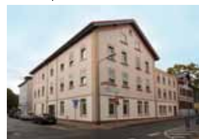
Albanusstraße 17 nach dem Umbau © drw Architektinnen
