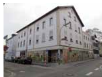
Albanusstraße 17 vor dem Umbau © NH ProjektStadt
