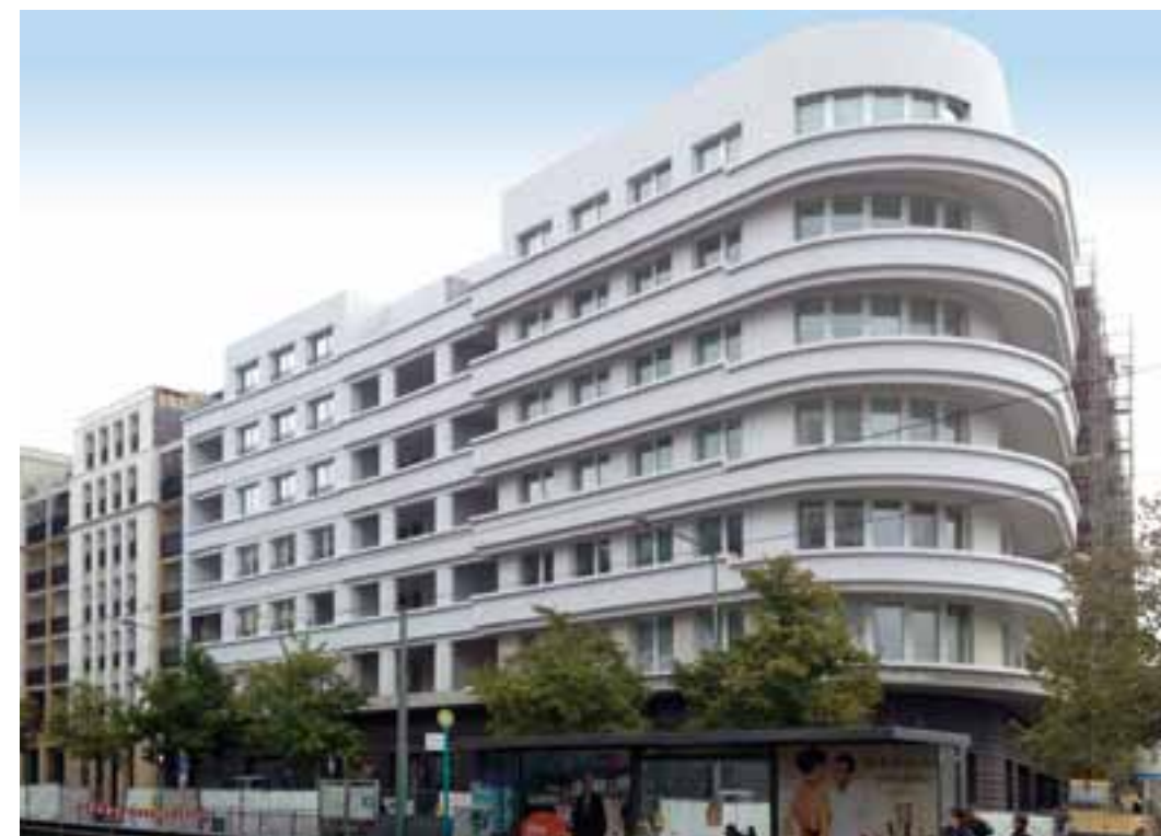
Gräfrstraße © ABG Frankfurt Holding
