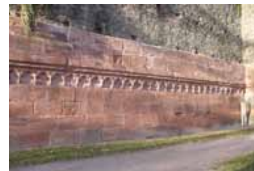
Stadtmauer nach Sanierung des Bruchsteinmauerwerkes © Lotte Plechatsch
