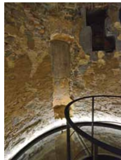
Innenbeleuchtung der Galluswarte
