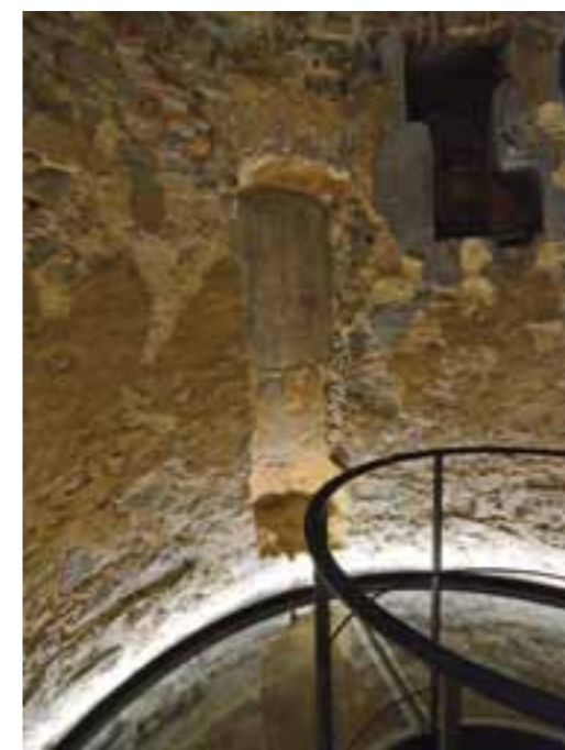
Innenbeleuchtung der Galluswarte
