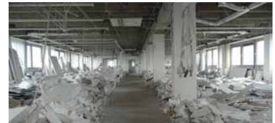
Entkernung des Bürogebäudes Lyoner Straße 30 © Fritz Ludwig Architekten
