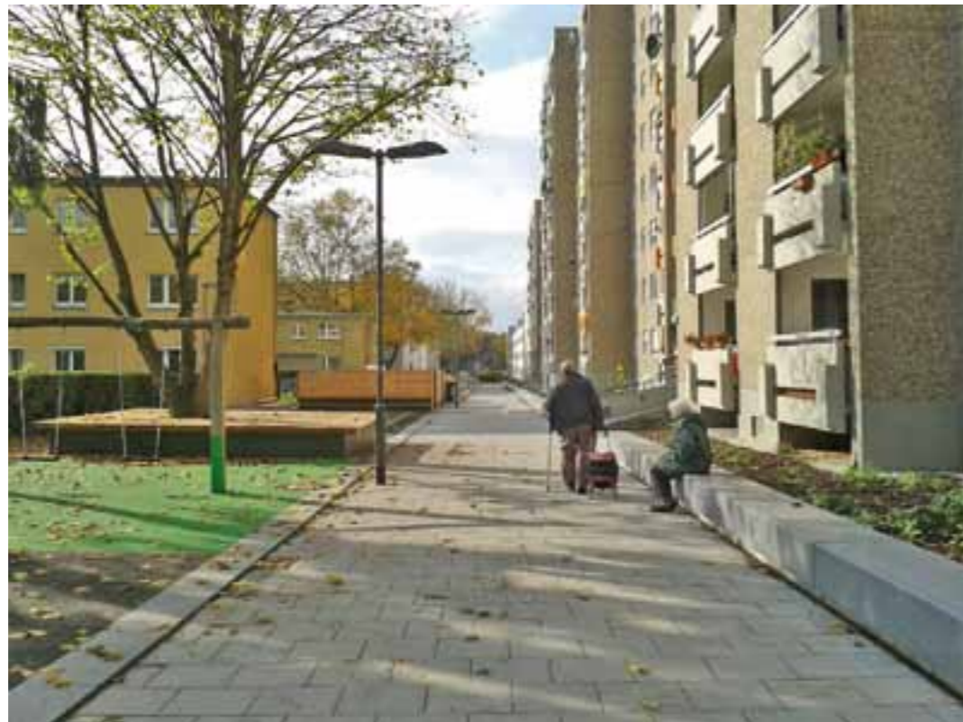
Teilabschnitt Cheruskerweg Aufweitung West nach der Umgestaltung
