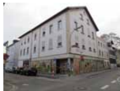
Albanusstraße 17 vor dem Umbau © NH ProjektStadt
