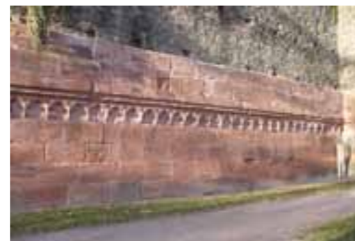
Stadtmauer nach Sanierung des Bruchsteinmauerwerkes © Lotte Plechatsch
