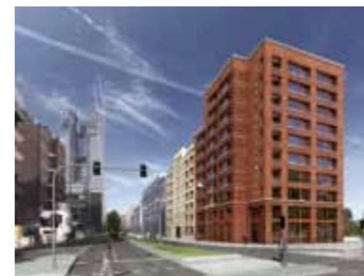
Hochpunkt am Brückenkopf, Blick auf die „Oskar Residence“ Richtung EZB © Stefan Forster Architekten
