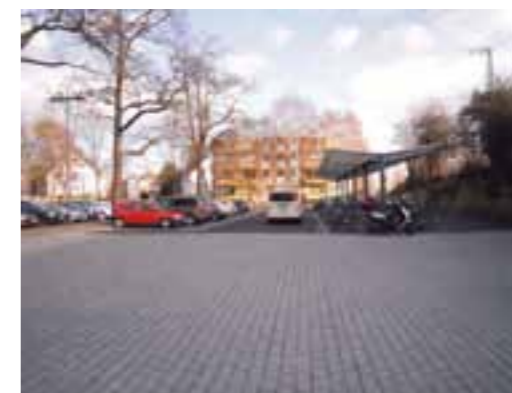
Neuer Platz und Fahrradabstellanlage auf der Nordseite
