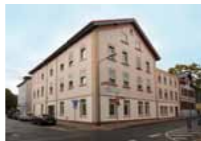
Albanusstraße 17 nach dem Umbau © drw Architektinnen
