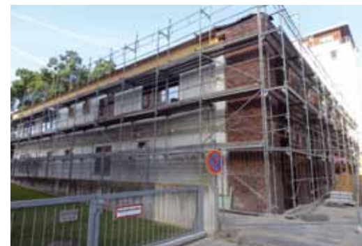
Baustelle Kita Oskar-von-Miller-Straße 2013
