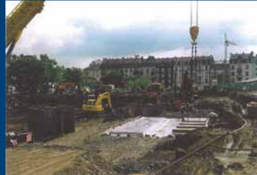
Baustelle Wohnhof Ostendstraße 1998
