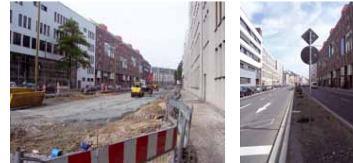
Bauarbeiten Erschließung Sonnemannstraße – Oskar-von-Miller-Straße – Rückertstraße 2005 und 2010
