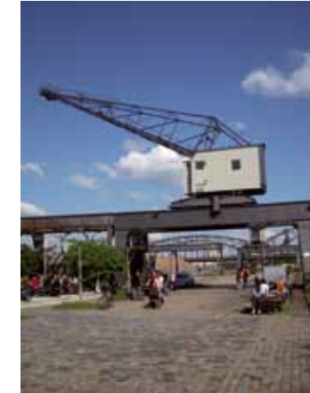
Kran nach der Sanierung 2009
