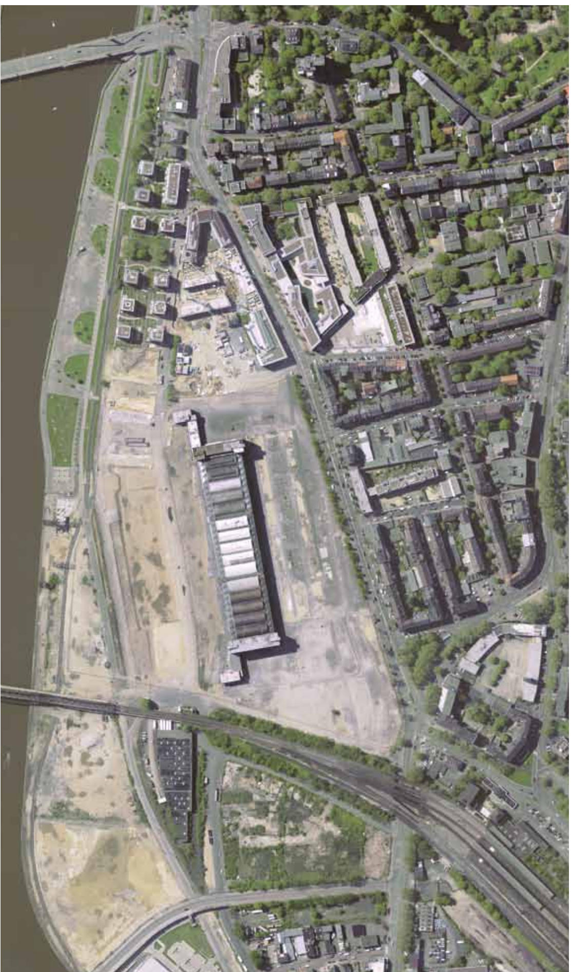
Luftbild 2005 (Quelle: Stadtvermessungsamt Frankfurt am Main)
