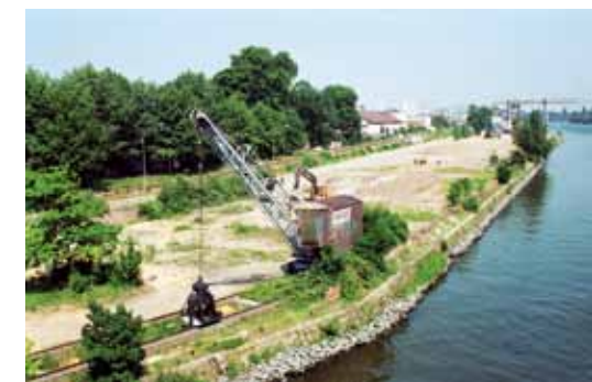
Baumaßnahmen Weseler Werft mit Kran
