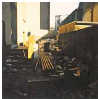
Uhlandstr. 56 vor der Modernisierung
