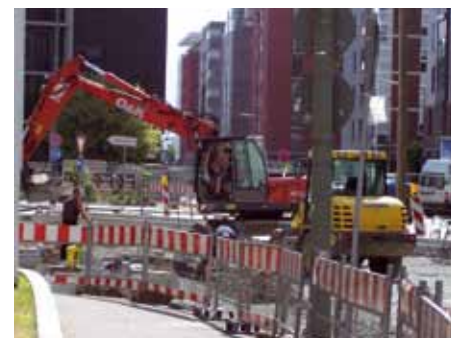
Erschließungsmaßnahmen Sonnemannstraße – Oskar-von-Miller-Straße 2008
