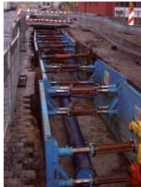
Leitungsverlegung Erschließung Oskar-von-Miller- Straße 2007/2008
