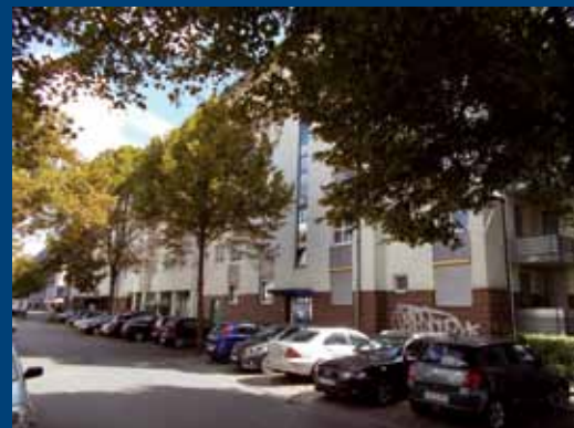
Oben links und rechts: Wohnhof Ostendstraße 30-42 2014
