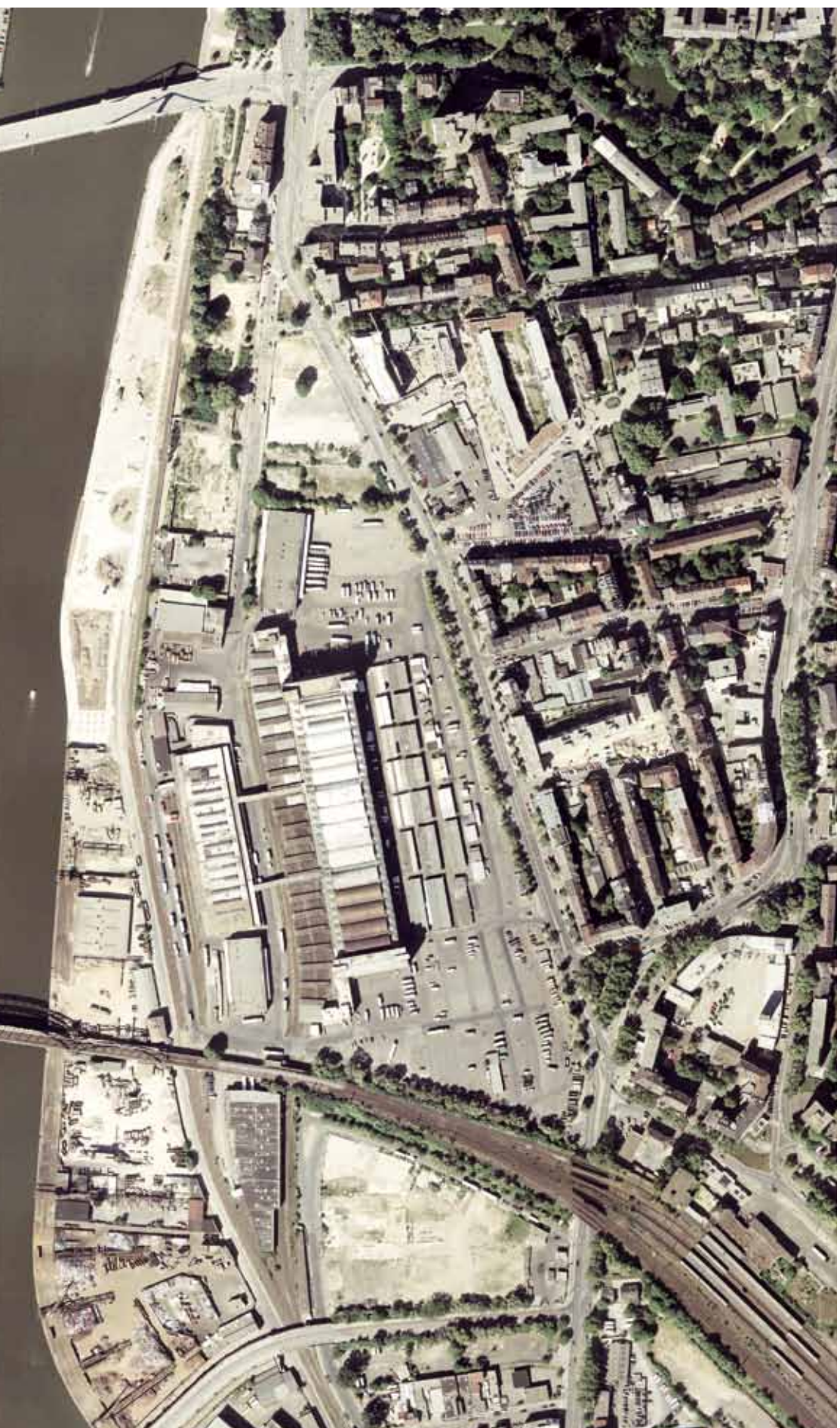
Luftbild 2000 (Quelle: Stadtvermessungsamt Frankfurt am Main)
