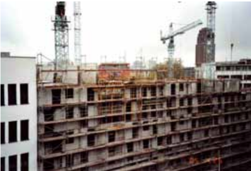
Bauarbeiten Sonnemannstraße 12-16 2005 und 2007
