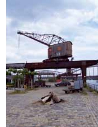
Kran vor der Sanierung 2006
