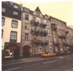
Windeckstraße 19 vor der Modernisierung
