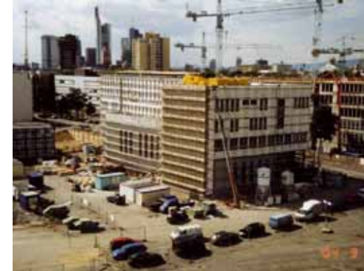
Bauarbeiten Dr. Hoch's Konservatorium 2004
