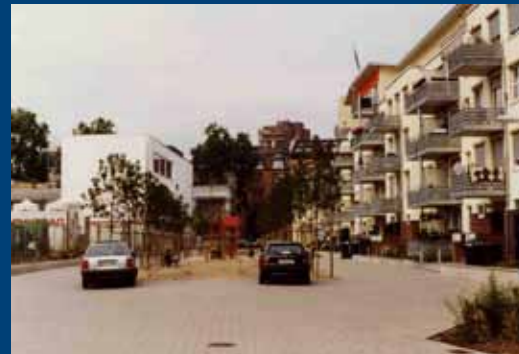
Oben links und rechts: Wohnhof Ostendstraße 30-42 2000
