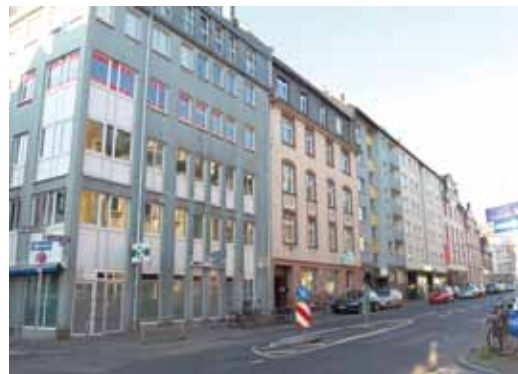
Straßenquerung Lorschei Straße
