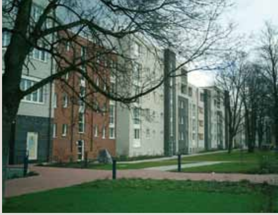
New Betts: Straßenansicht Gebäude Friedberger Landstraße
