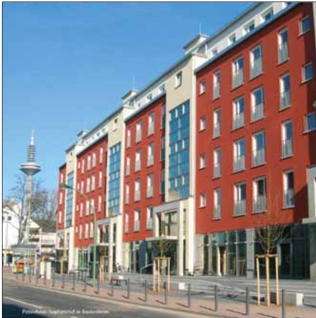
Passivhaus: Nachhaltig und zu bewohnen
