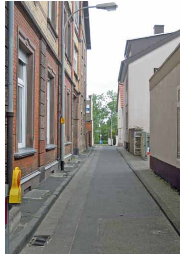
Bestandsituation in der Plessengasse und
