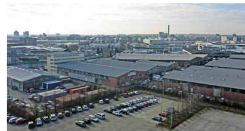
Bebauung im Industriegebiet Ferdinand-Porsche-Straße
