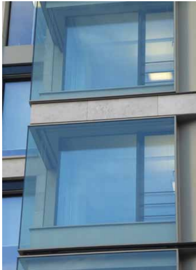
Kastenfenster mit feststehender Außenscheibe und seitlichen Lüftungsklappen
