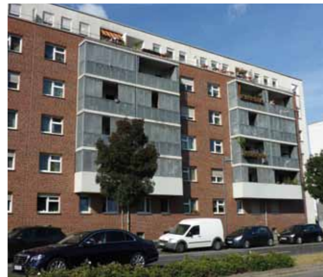
Balkone mit verschiebbaren Schutzelementen. Damit ist kein TA-Lärm-konformer Schutz vor Gewerbelärm möglich
