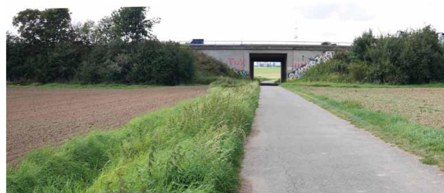
Bestehende Querung der BAB 5
