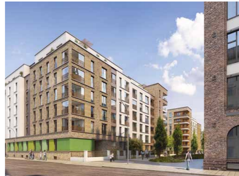
Kleyerstraße: Westansicht © SWI Schimpel & Winter Hausbau GmbH
