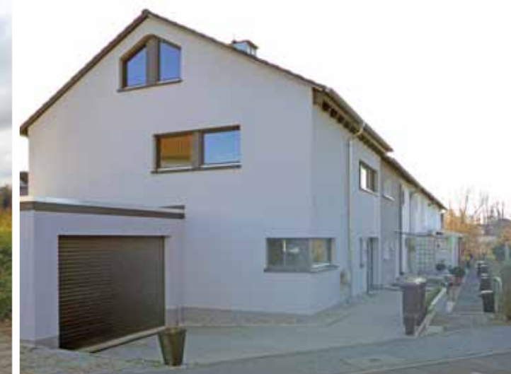
Energetische und funktionale Modernisierung eines Reihenendhauses – nach der Modernisierung, Frankfurter Berg
