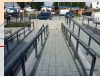
Treppen und barrierefreie Rampen überwinden den Höhenunterschied von bis zum 4m
