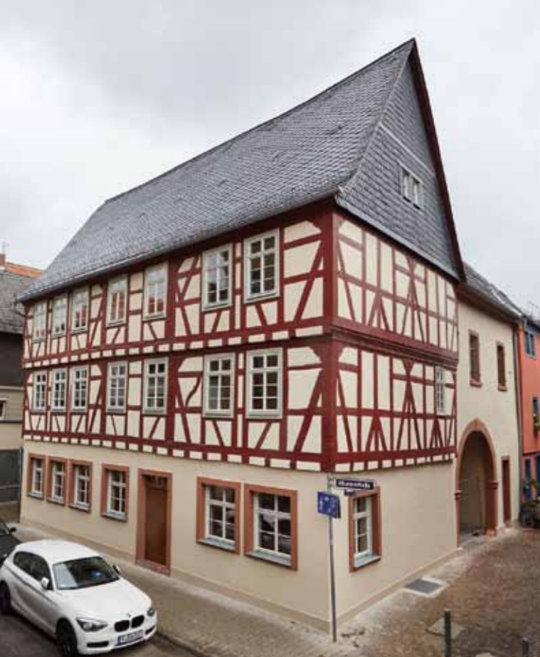
Denkmalgerecht saniert: der Goldene Adler © Michael Meisen
