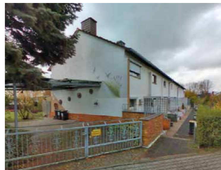
Zustand vor der Modernisierung, Frankfurter Berg
