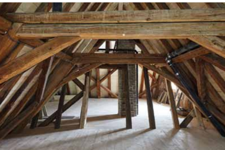
Reparierter Dachstuhl © Michael Meisen
