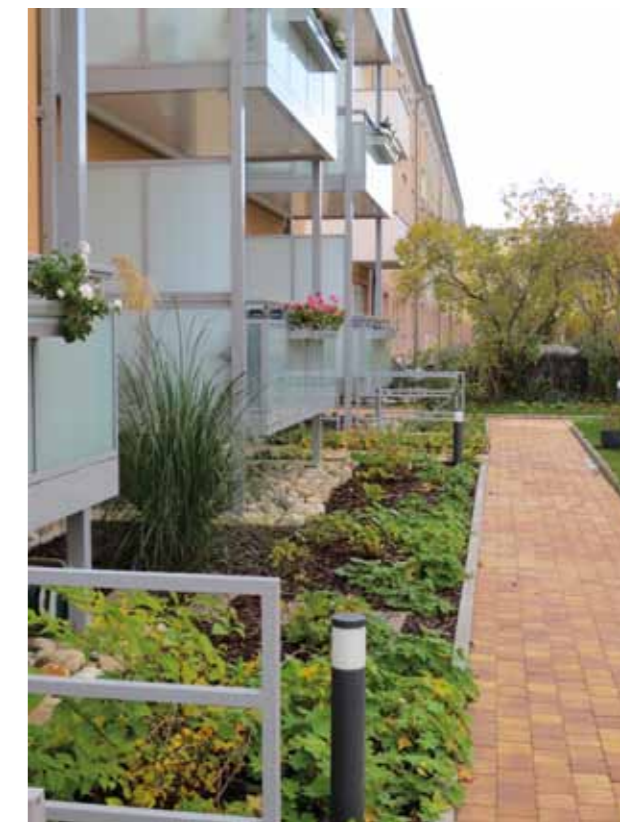
Mehrfamilienhaus in Niederrad: rückseitiger Anbau von Balkonen
