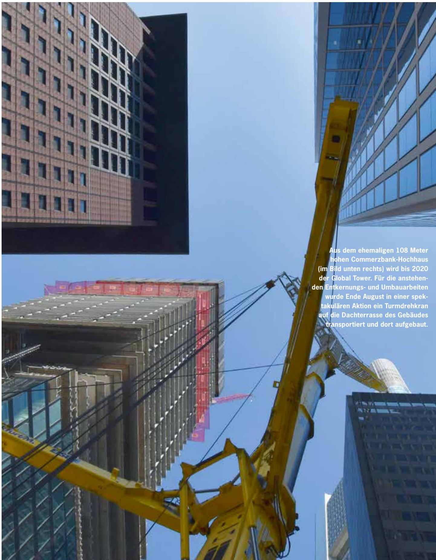
Aus dem ehemaligen 108 Meter hohen Commerzbank-Hochhaus (im Bild unten rechts) wird bis 2020 der Global Tower. Für die anstehenden Entkernungs- und Umbauarbeiten wurde Ende August in einer spektakulären Aktion ein Turmdrehkran auf die Dachterrasse des Gebäudes transportiert und dort aufgebaut.
