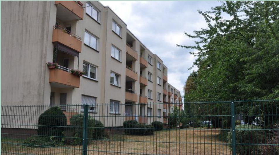
Sanierung / Nachverdichtung Wohnungsbestände Ahornstraße / Froschhäuser Straße / In der Schildwacht
