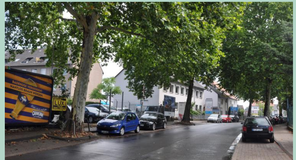
Ausbau des Digitalnetzes
