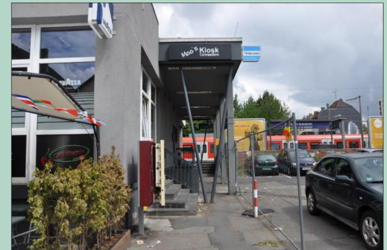
Autogenstraße / Zugang Bahnsteig
