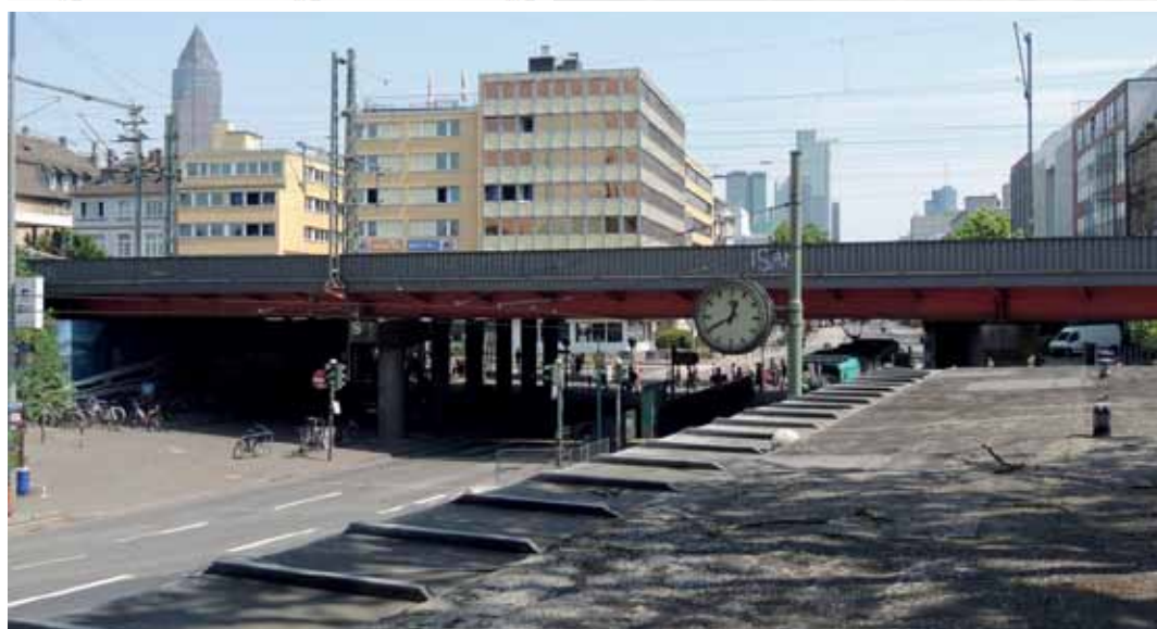
Blick auf die Bahn- station Galluswarte
