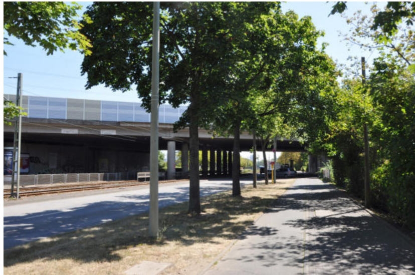
Mainzer Landstraße / Bundesautobahn A 5
