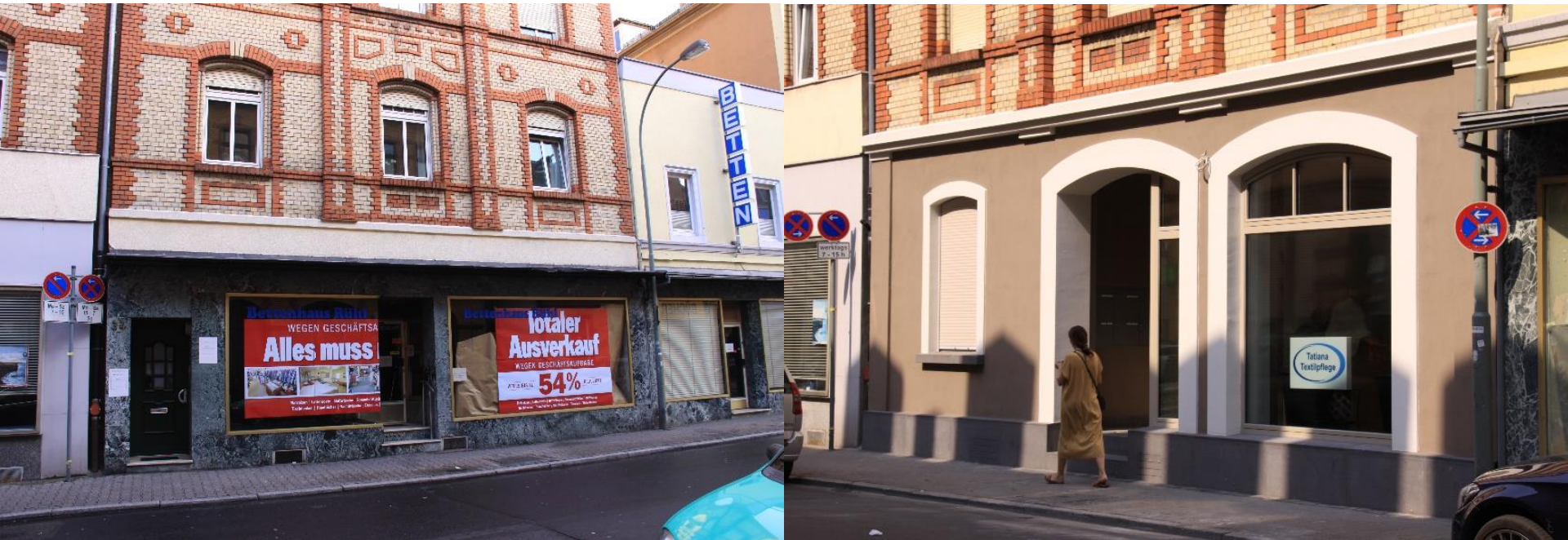
Zustand vor und nach Umbau
