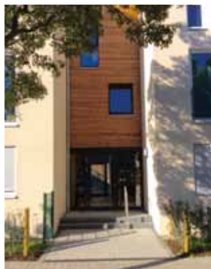
Stadthäuser Gotenstraße; Baufrösche Kassel
