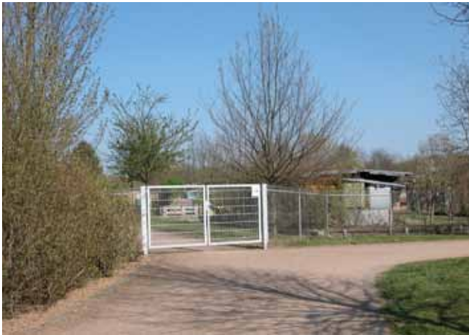
Zustand vorher : Tor zur Kleingartenanlage
