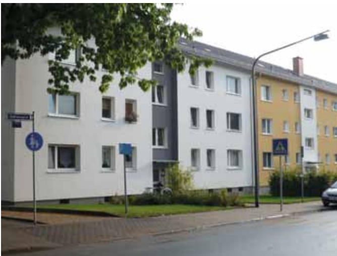
Rugierstraße nach der Modernisierung
