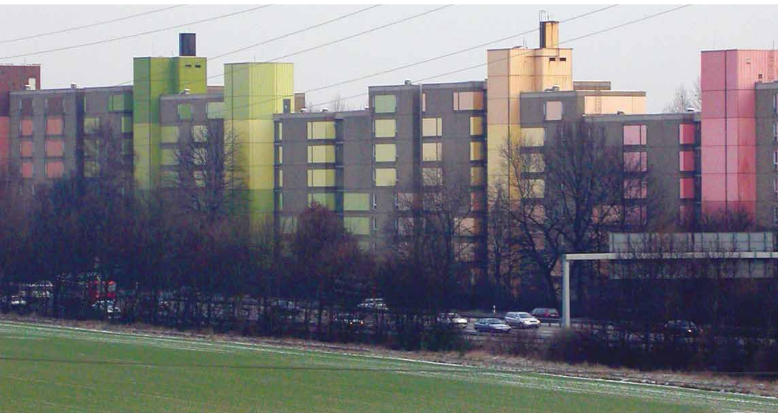
Südfassade mit neuer Farbgebung
