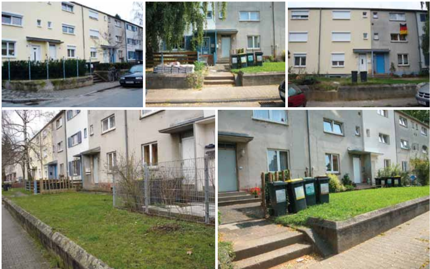
Zustand vorher (Alemannenweg, Abschnitt Engelsruhe/Chattenweg)
