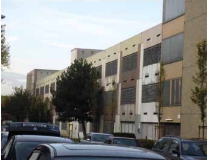
Parkhaus im Cheruskerweg vor der Sanierung
