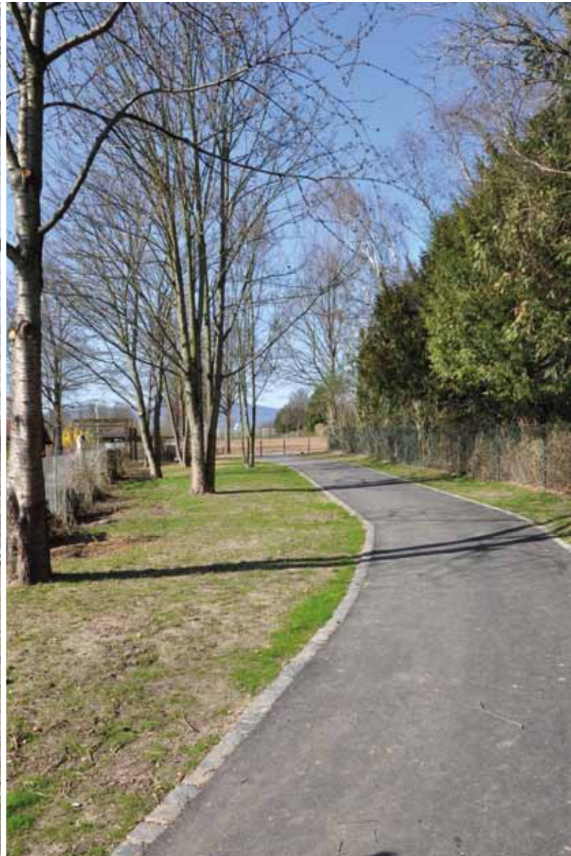
Nach der Fertigstellung (2. Bauabschnitt)
