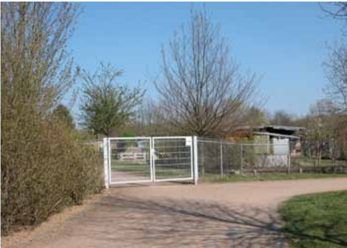
Zustand vorher : Tor zur Kleingartenanlage
