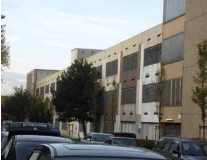
Parkhaus im Cheruskerweg vor der Sanierung
