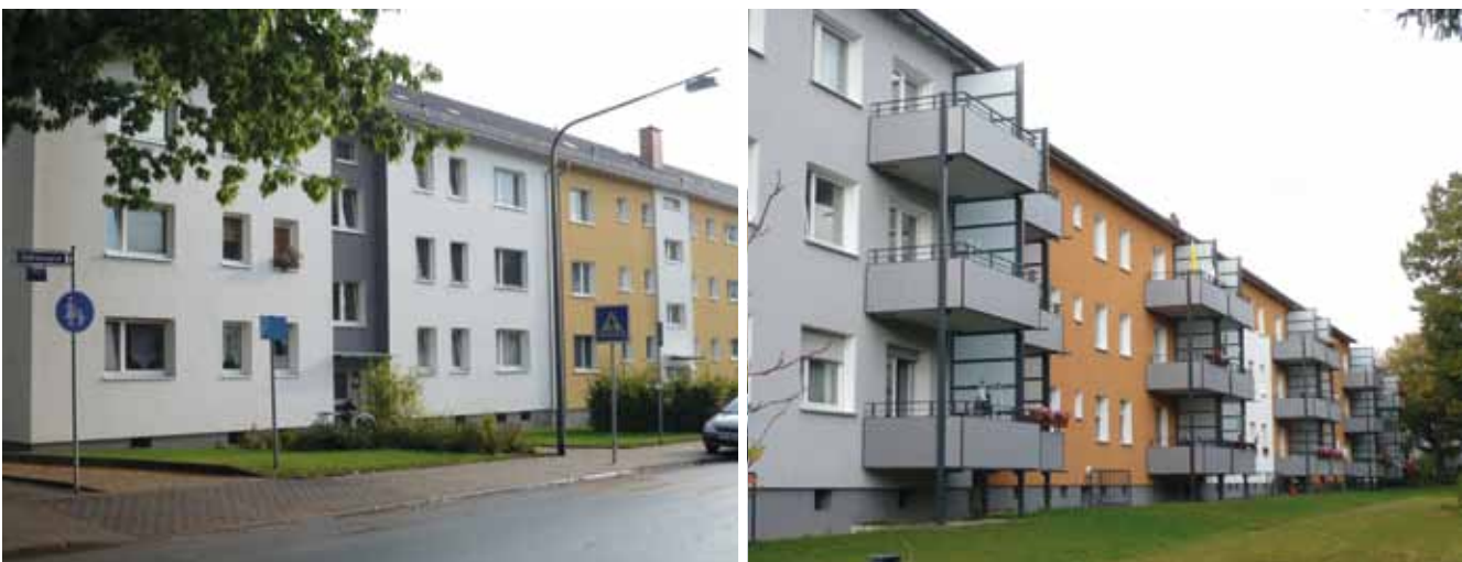
Rugierstraße nach der Modernisierung
