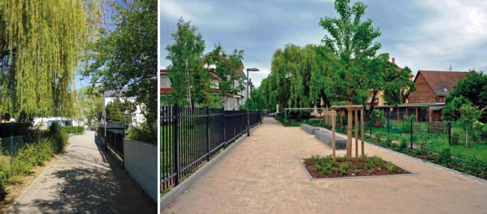
Wegeverbindung nach der Fertigstellung (Ambronnenpfad); Gestaltungskonzept/Entwurf: Büro Wittich
