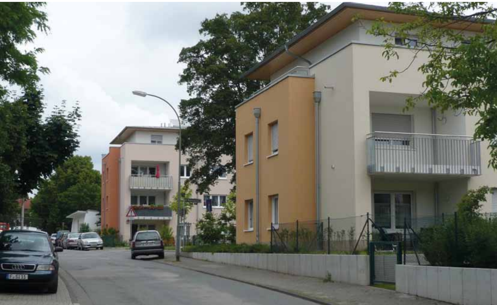
Engelsruhe/Markomannenweg (Bauherr Hellerhof GmbH, Sozialer Wohnungsbau)
