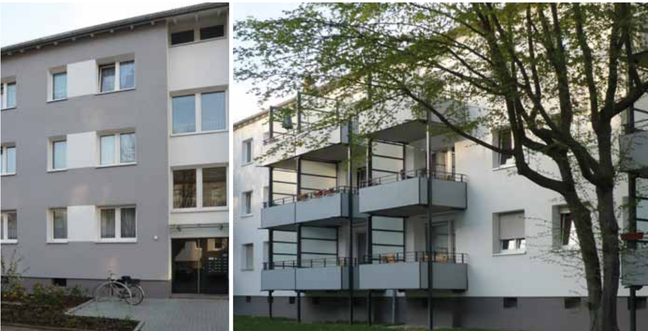
Alemannweg nach der Modernisierung, Rückseite mit neuen Balkonen
