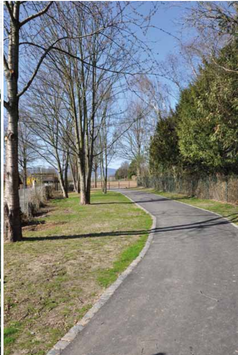
Nach der Fertigstellung (2. Bauabschnitt)
