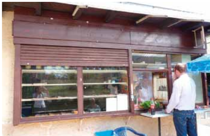
Kioskgebäude vor der Renovierung
