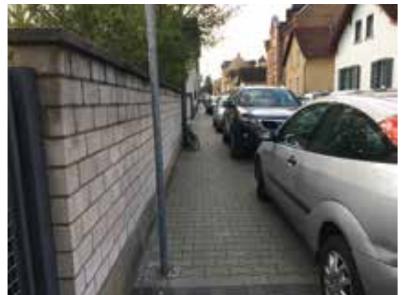
Abbildung 55: Beispiel für einen nicht barrierefreien Gehweg im Quartier Alt-Nied (ProjektStadt, 2019)
