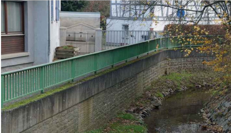
Foto 38: Aufweitungsbereich Am Faulbrunnen
