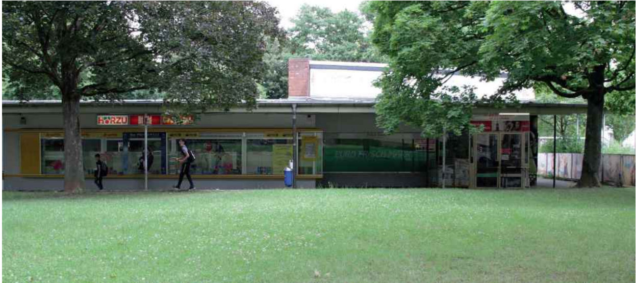
Foto 77: Nahversorgungszentrum Schaumburger Straße
