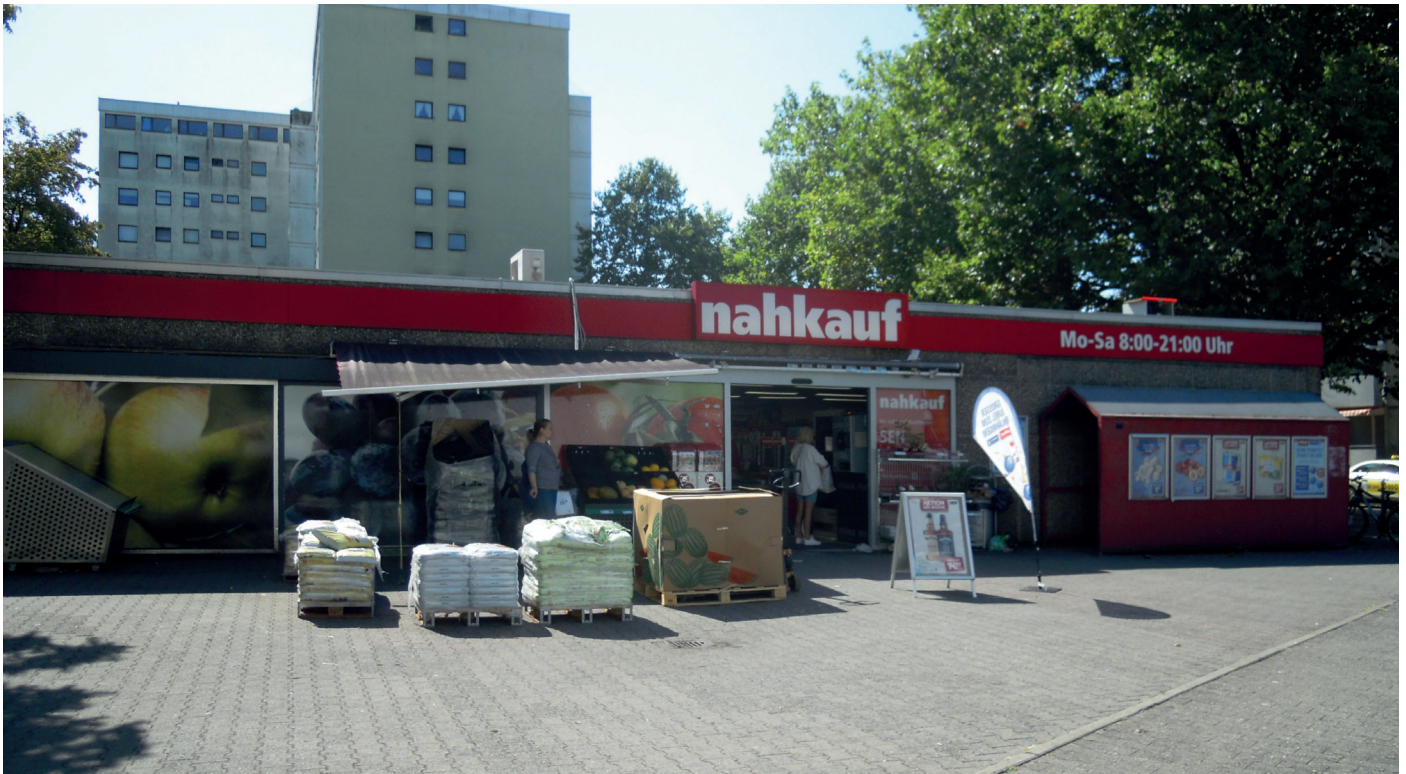
Störfaktor in der Nachbarschaft: Eingeschossiger Markt inmitten von verdichteten Siedlungsgebieten (Frankfurt am Main-Nied Dürkheimer Straße 40)
