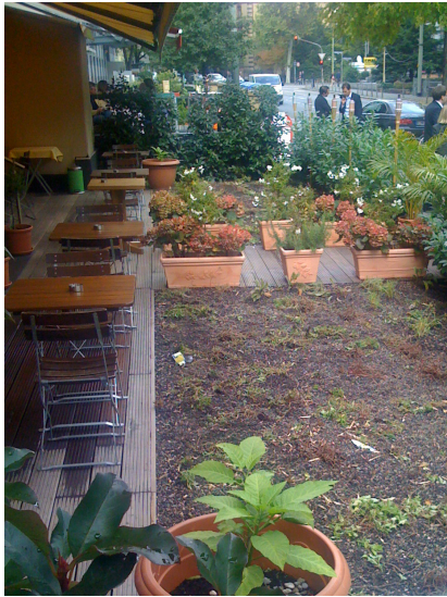
Verwendung von Ökopflaster und intensiver Begrünung als Kompensationsmaßnahme für die Befestigung des Vorgartens.
