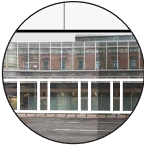
unattraktive Fassaden mit Servicezugängen
