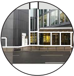
unattraktive Fassaden mit Servicezugängen
