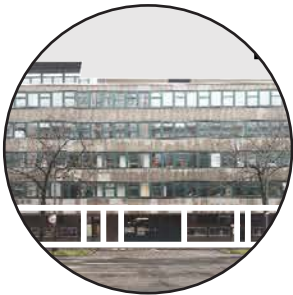
unattraktive Fassaden mit Servicezugängen
