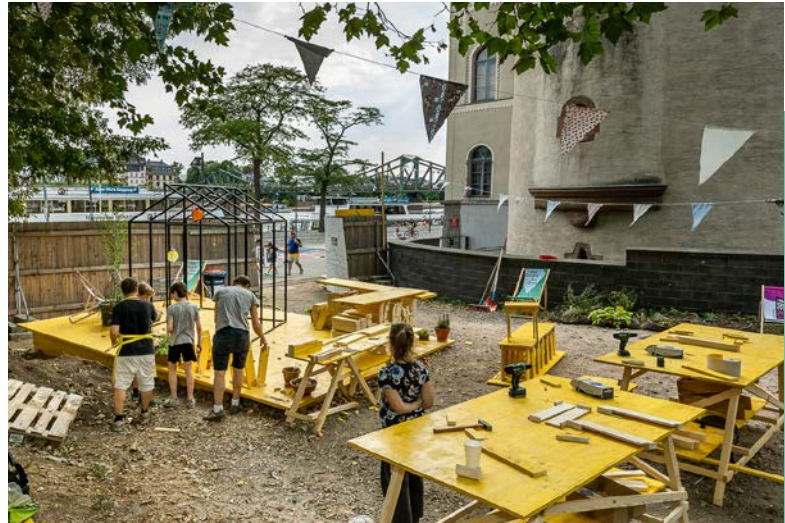
Bau temporärer Stadtmöbel in Frankfurt am Main, Quelle: Cornelius Pfannkuch
