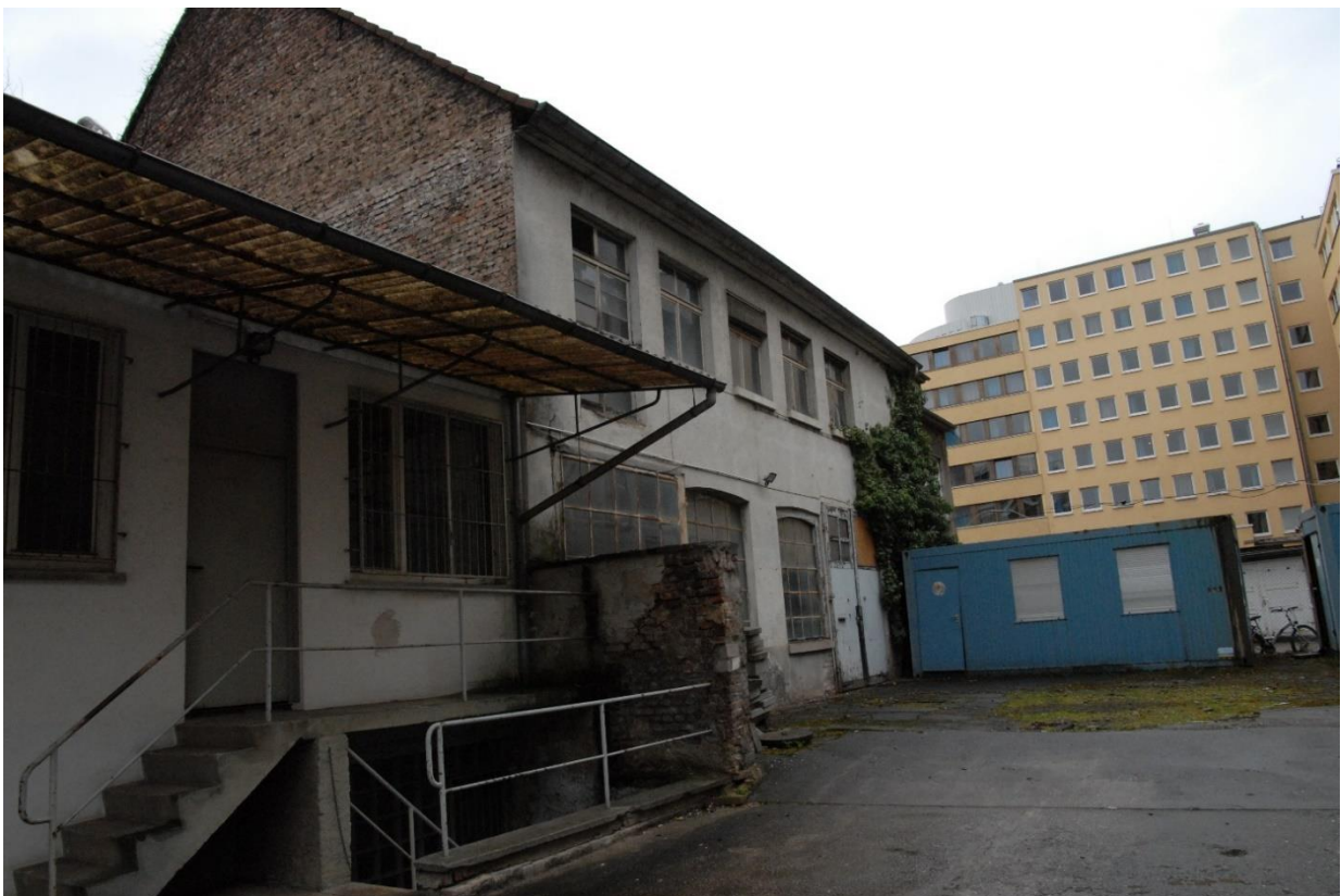
Foto 4 Innenhof mit alter Schmiede (unterkellert)
