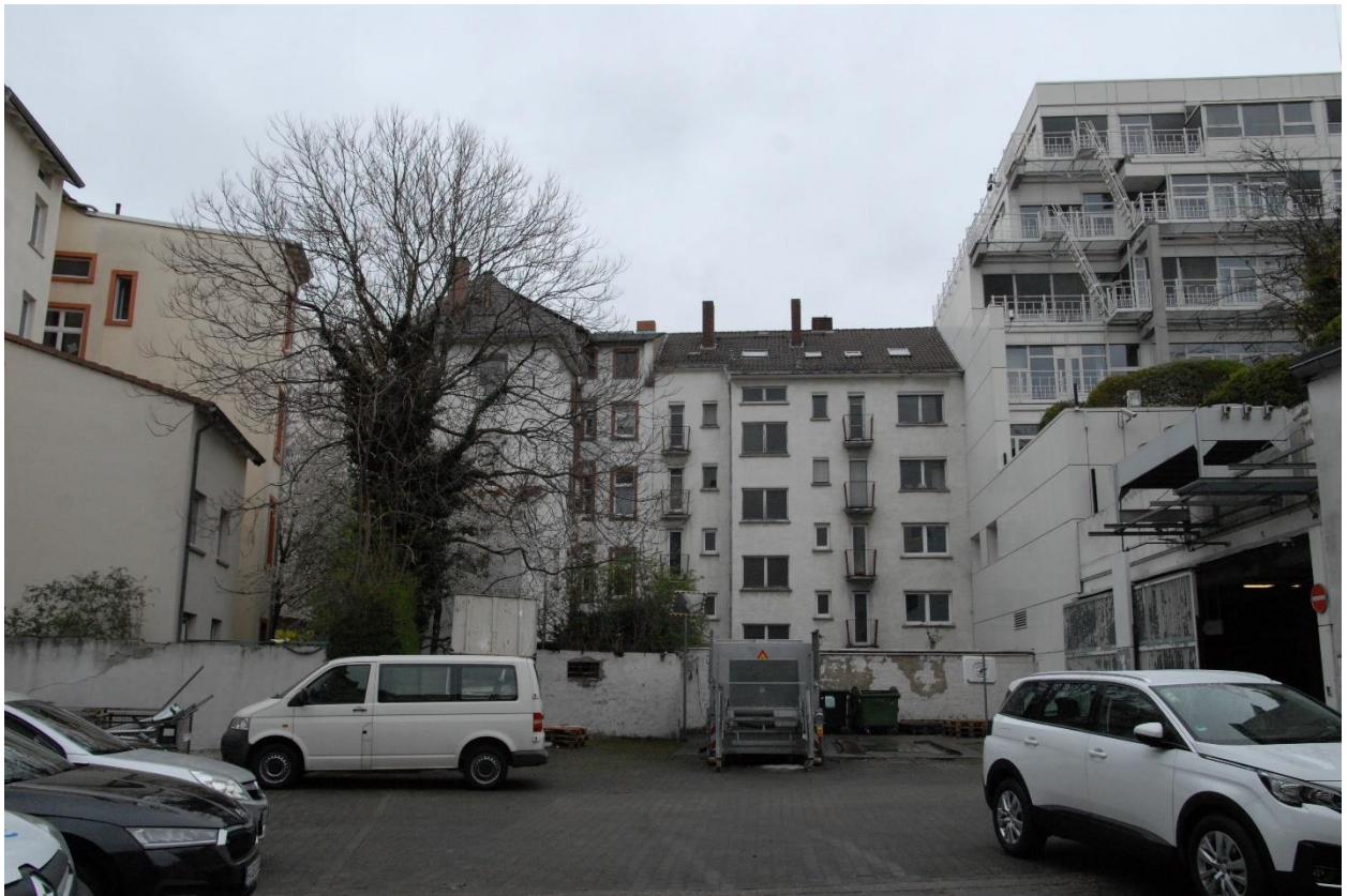
Foto 5 Der gleiche Innenhof mit Blick auf Abrissgebäude an der Frankenallee
