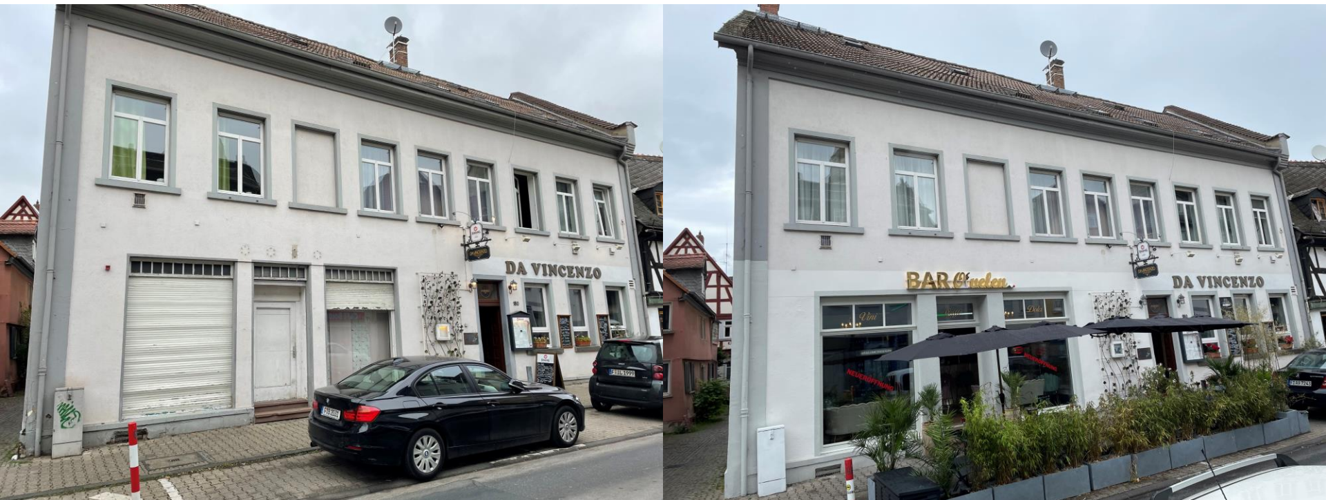
Fassade Zustand vor und nach Umbau
