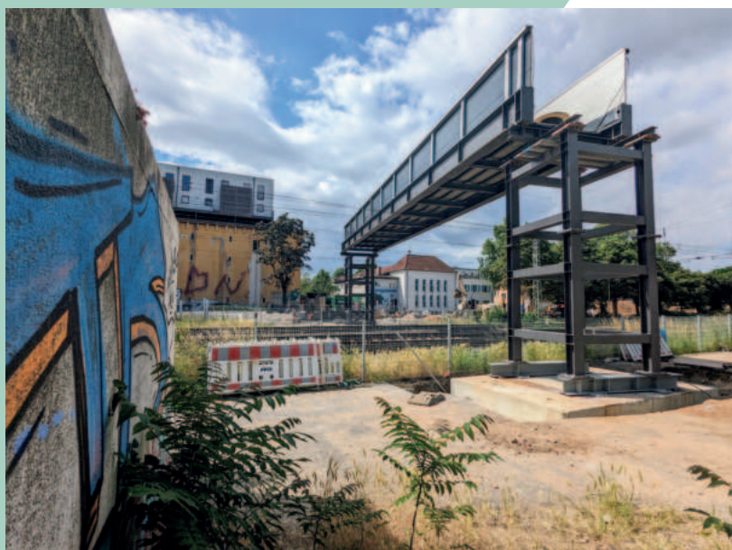
Bau der Behelfsbrücke © BSMF mbH
