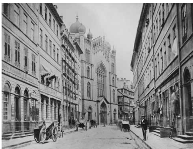
Börnestraße mit Blick nach Süden auf die Hauptsynagoge um 1885 © Institut für Stadtgeschichte Frankfurt am Main
