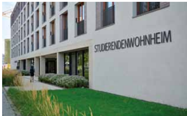
Riedbergallee 4 © Studierendenwerk Frankfurt am Main
