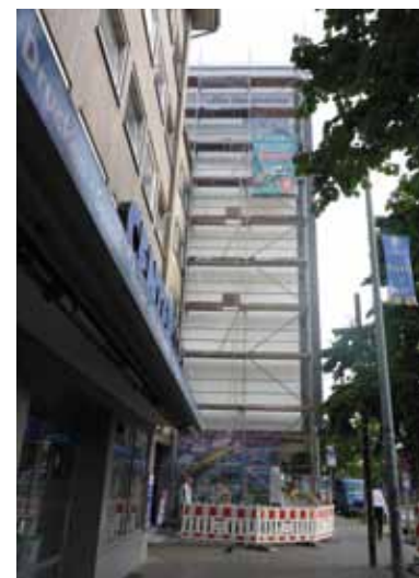
Die Wandfläche Kurt-Schumacher-Straße 41 während der Umgestaltung
