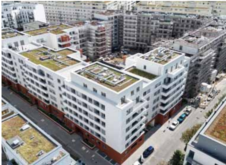
Baustelle, Gesamtes Quartier © Swiss Life Asset Managers Deutschland GmbH
