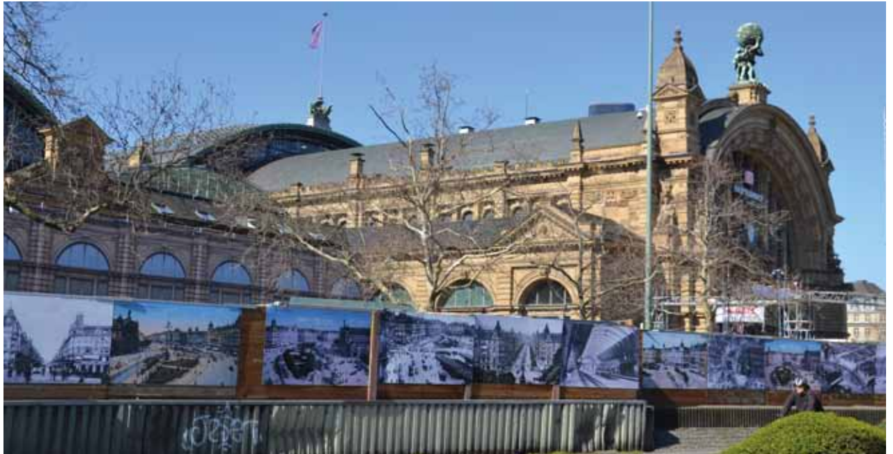
Gestaltung Bauzaun am Hauptbahnhof
