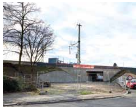
Erster Schritt: Tunnelbauwerk erstellt
