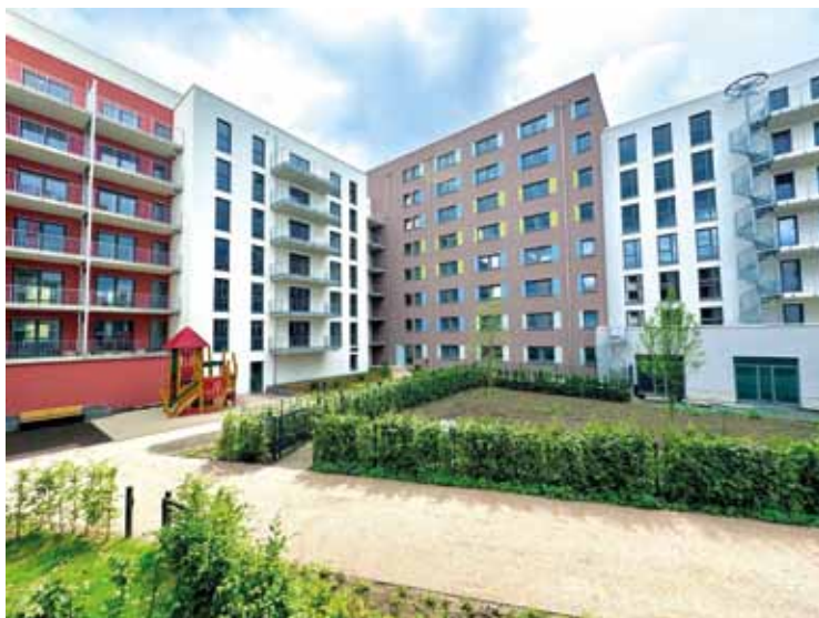
Hofansicht, Baufelder D3 und E2 © Nassauische Heimstätte Wohnungs- und Entwicklungsgesellschaft mbH
