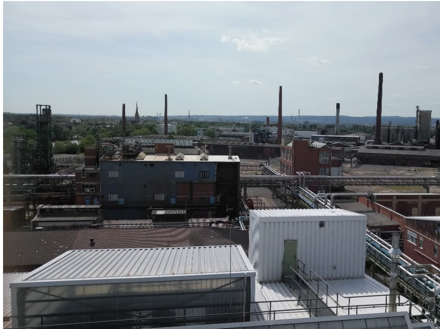
Blick auf die Bebauung im Industriepark Griesheim © Stadtplanungsamt Frankfurt am Main
