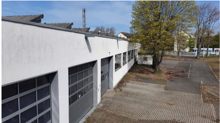
Abb. 11: Das Foto aus der Gegenrichtung (s. Abb. 10) zeigt weitere Bäume entlang der vormals gewerblich genutzten Gebäude.
