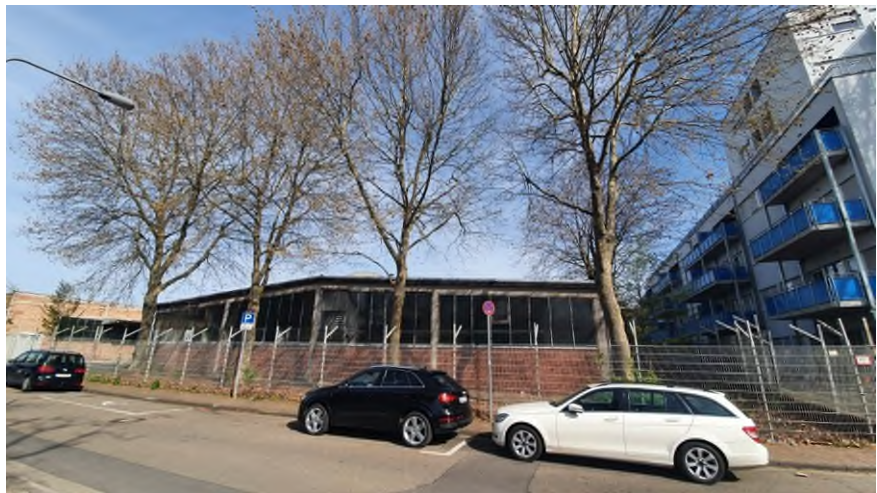
Abb. 12: Um die Halle im Südosten des Geltungsbereichs erstreckt sich ein Grünstreifen mit Bäumen.
