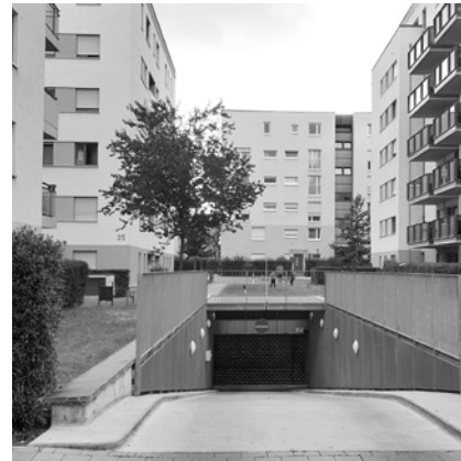
Freiliegende Tiefgaragenrampen im Außenbereich sollten vermieden werden.
