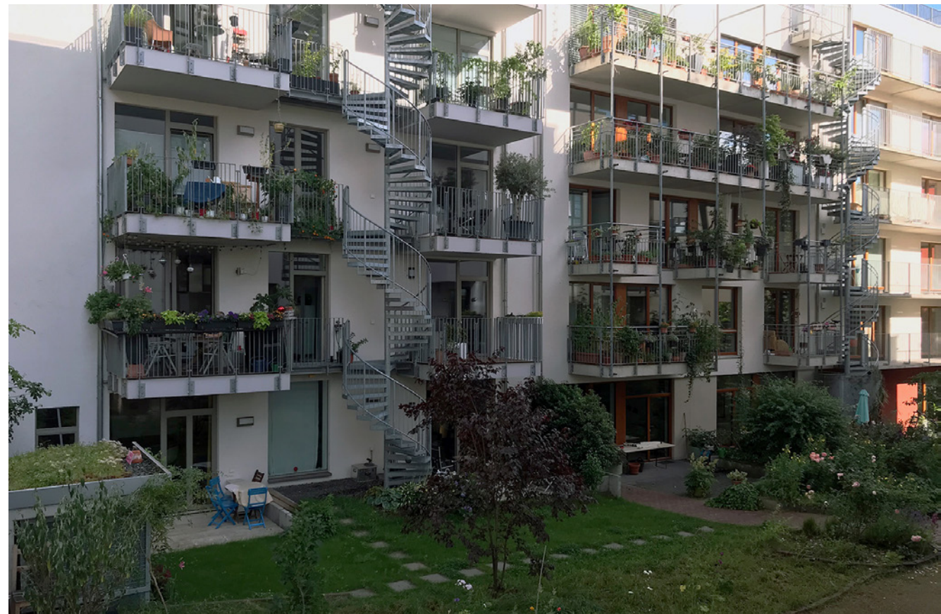
Gartenseitige Fluchttreppe als zweiter Rettungsweg (Naxos-Areal).
